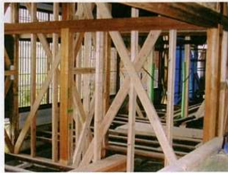
1階北側和室の筋合い補強（2006.7.26）
