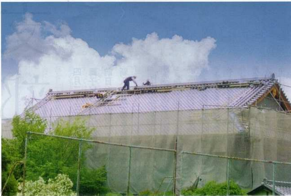
新しい瓦に葺きかえられた佐保会館大屋根（2006.6.12）
