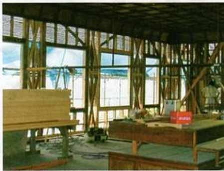
2階ホールの北面窓枠を取り外し、壁の補強（2006.7.26）
